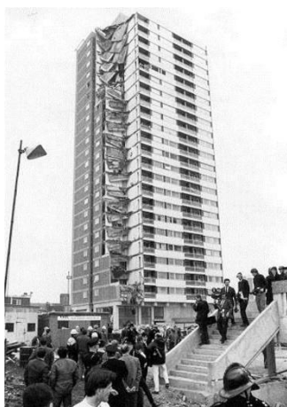
Figura 2.1 – Ronan Point após colapso, adaptado de [16].
