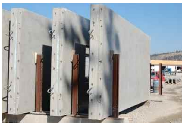
Figura 2-5 - Exemplo de parede prefabricada simples [adaptado de [20]].
