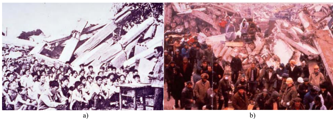
Figura 3 - a) Colapso de edifícios pré-fabricados em Tangshan, República Popular da China em 1976 [7]; b) Colapso de edifícios pré-fabricados em Leninakan, Arménia em 1988 [7].
